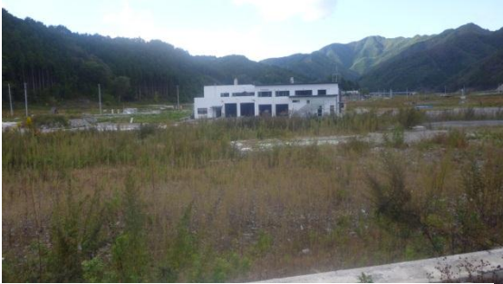
津波にのまれた避難所に指定されていた消防署。周囲は住宅密集地であったという。
